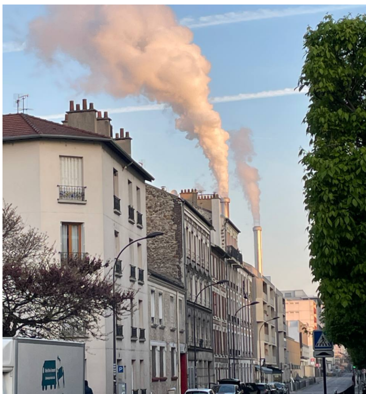
Vue de l'incinérateur d'Ivry/Paris XIII depuis la rue Jean-Jacques Rousseau à Ivry-sur-Seine © Collectif 3R, 2023.
