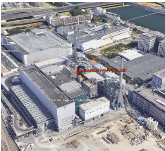
Figure 1 : Incinérateur Ivry-Paris XIII Ivry-Paris XIII (Google Earth)
